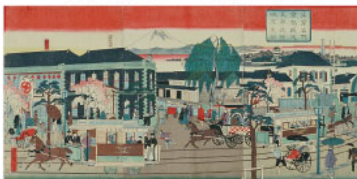
21) 東京名所 京橋鉄道馬車往復煉瓦家ノ図 歌川広重(三代) 明治15年(1882)
