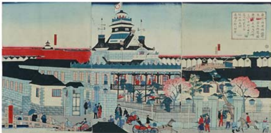
18) 東京海運橋兜町為換座五階造り図 歌川広重(三代) 1873年(明治6)
